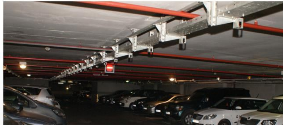
Гаража „Пионирски парк“ - замењен спринклер систем и хидрантска мрежа
